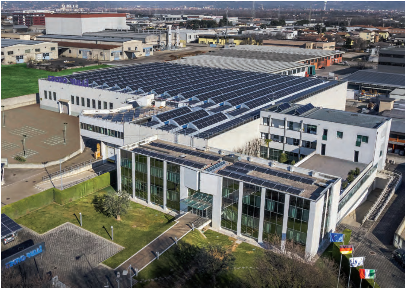
Werk 1 Verwaltung und Produktion Centro de producción principal y oficinas
